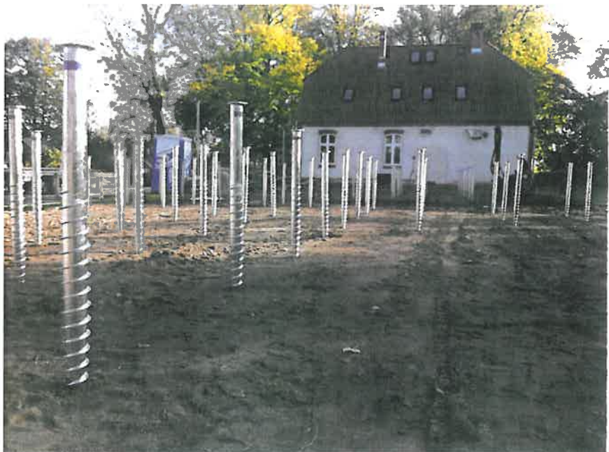
Abb. 1: Ein Fundament aus Schraubelementen dient als Gründung.
